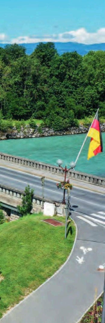
Le Pont de l'Europe va subir un lifting important
