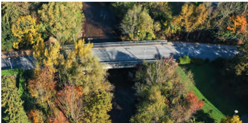
Le pont de Tucinge enjambe le Borne, dont les digues seront bientôt renforcées
